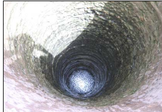
Puits de surface SAMPEMA
